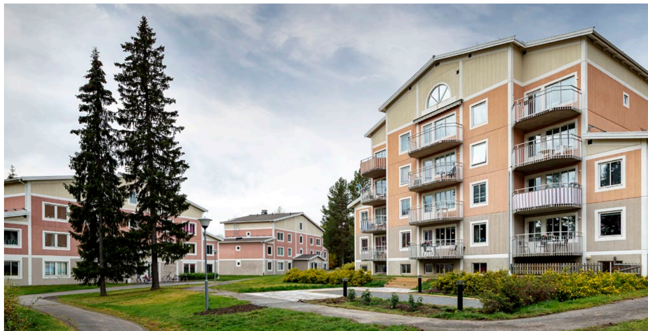
Fastigheten Yllemattan, Östersund.
