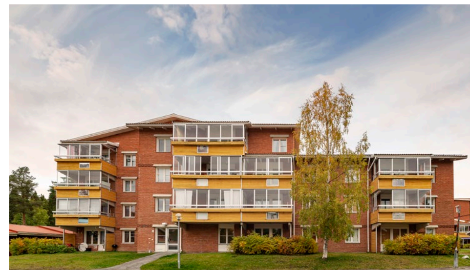
Fastigheten Bakplåten, Östersund.
