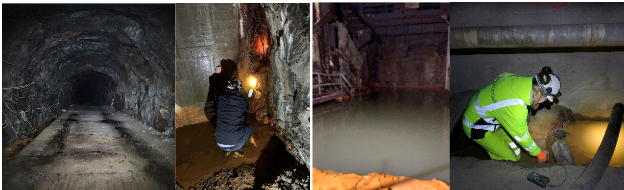
Figur 4-2: Fra venstre: veien i hovedstoll med kanal på venstre side, prøve St 2_MC ved betongplugg, prøvepunkt i knuseverk – hvor slam kan skimtes nederst i bildet, prøvepunkt gruve J3_MC i kanal.
