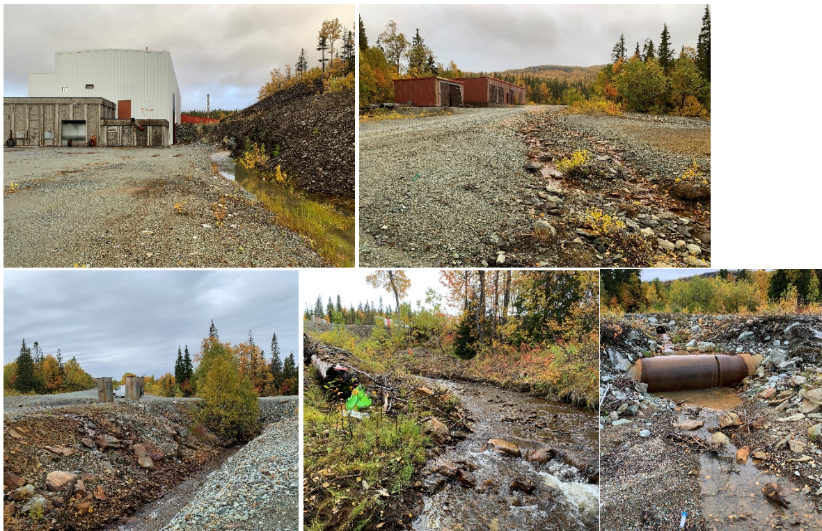
Figur 4-11: Øverst, fra venstre: Sig langs oppredningsverk (prøve ØHV_bekk4_MC), sig som mottar avrenning fra bl.a. smørebu og arealene bak denne (prøve ØHV_sig_MC). Sigene renner til prøvepunkt ØHV_bekk3_MC i Tippbekken. Nederst, fra venstre: Tippbekken som renner forbi tidligere lager for diverse utstyr og mellomlager for malm (prøve ØHV_bekk 3b_MC), Tippbekken nedstrøms lager (prøve ØHV_bekk 3a_MC), og Tippbekken like før den renner ut i Østre Hudningsvatn (prøve ØHV_bekk3_MC). Røret nederst til høyre ble etablert for å lede rene bekker nordøst for sjetéen.
