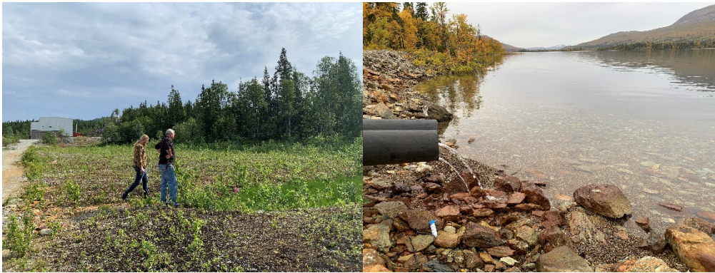
Figur 4-12: Til venstre: Tidligere slamdam som nå er dekt med rene masser og forsøkt vegetert. Til høyre: bekk/sig renner forbi slamdam, gjennom et rør og ut i Østre Hudningsvatn (prøve ØHV_bekk2_MC).
