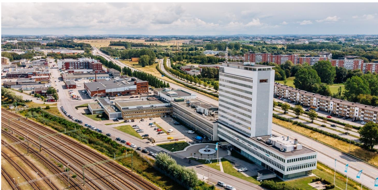
Fastigheten Cronholm 1, Malmö, lager-, kontor- och samhällsfastighet.
